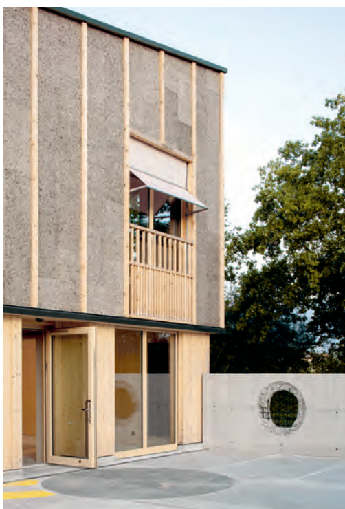
Fassade mit Fichtenholz und Korkdämmplatten.
