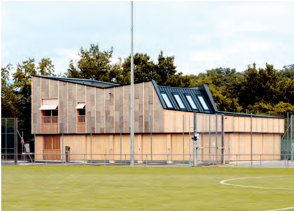
Im Obergeschoss befinden sich beheizte Räume, ebenerdig liegen die Werkstatt und die Einstellhalle.
